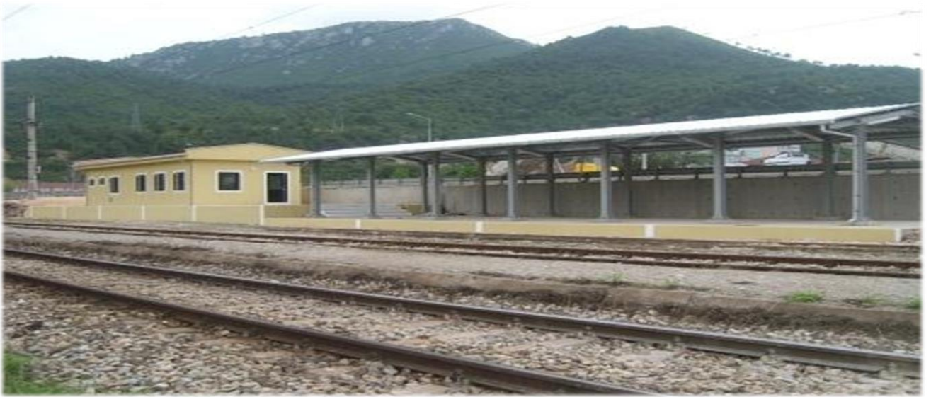
T.C. DEVLET DEMİR YOLLARI İSTASYON BİNASI YAPIMI T.C. STATE RAILWAYS STATION BUILDING
