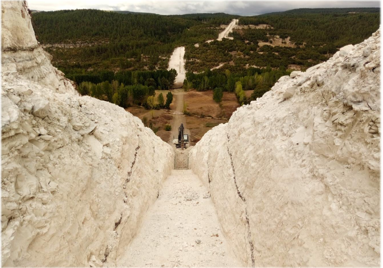
BURSA DAĞ İLÇELERİ 16" İLETİM VE KELES BAĞLANTI HATTI YAPIM İŞİ LOT 1.2
