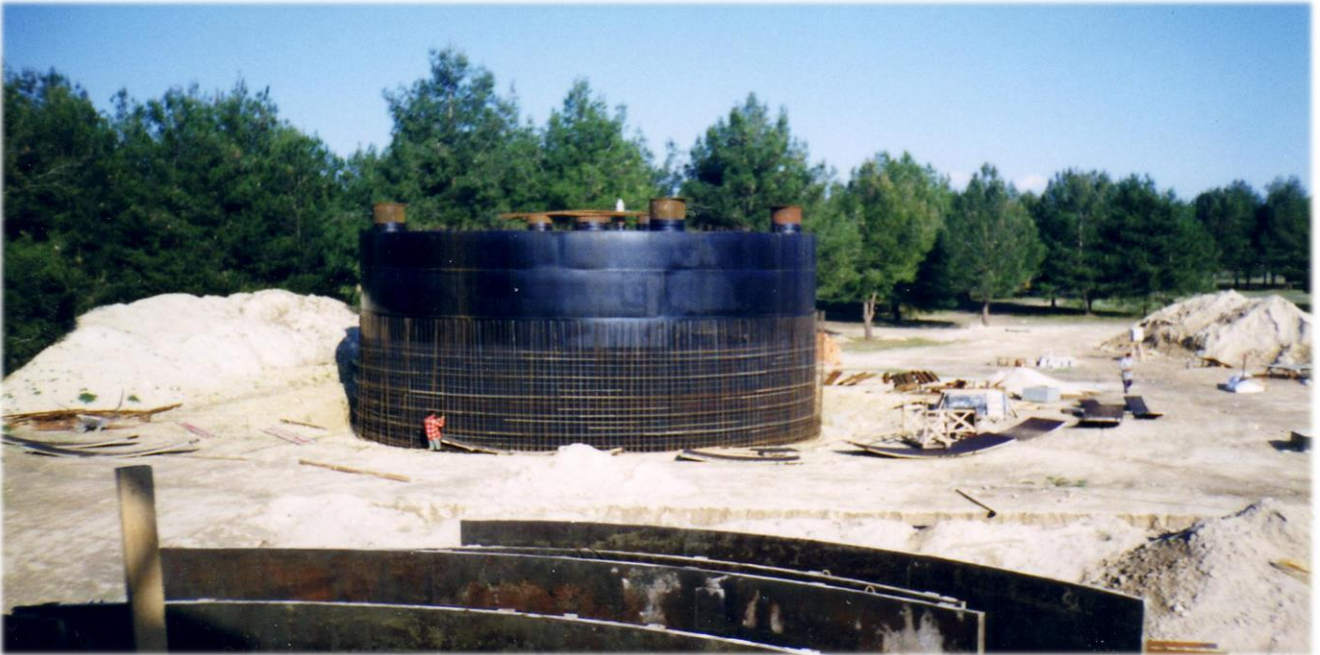
ANTALYA HAVA MEYDAN KOMUTANLIĞI YAKIT DEPOLAMA TANKLARI VE POL TESİSLERİ İNŞAAT İŞLERİ
