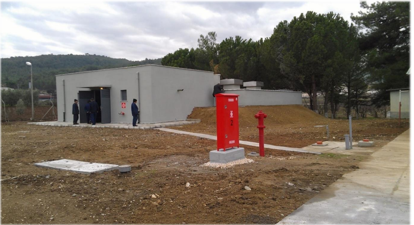
OSMANELİ POMPA İSTASYONU YANGIN HİDRANT SİSTEMİ YAPILMASI
